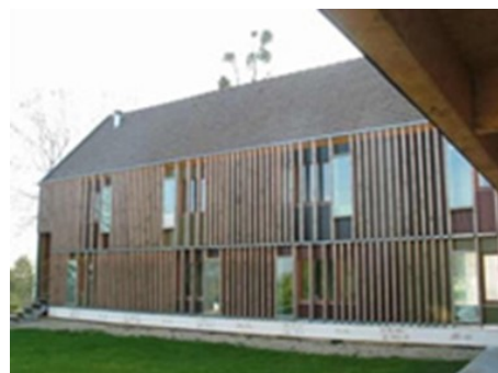
Façade du bâtiment de vie
